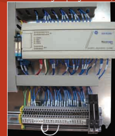
Controlador lógico programable (PLC)
